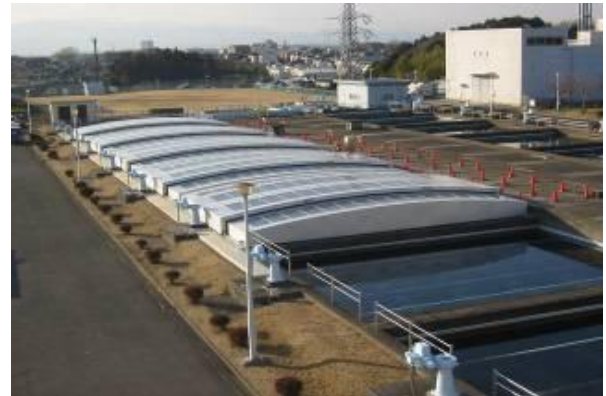
アルミ製可動式覆蓋(浄水場納入)
