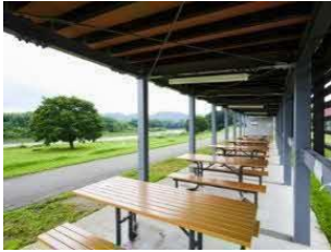
バーベキュー施設 (参考：道の駅常陸大宮)
