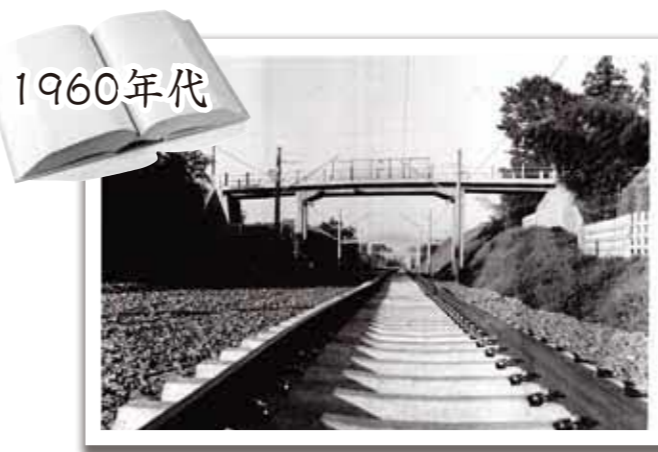
1964年 新幹線建設工事
