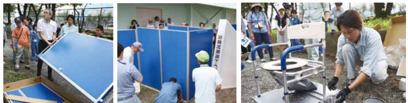
(写真左) (写真中) パネル式になっているので、ビスを用いて大人3～4人で簡単に組み立てることができる。屋根もあるので雨よけ、防犯などにも配慮がされている
