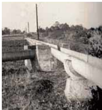
U字管設置の様子
