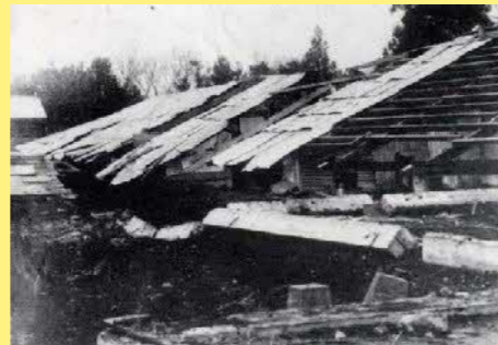
同震災で倒壊した綾瀬小学校
