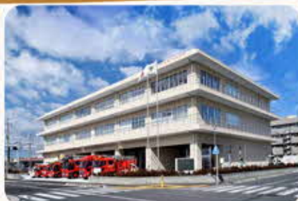
綾瀬市消防本部・消防署
