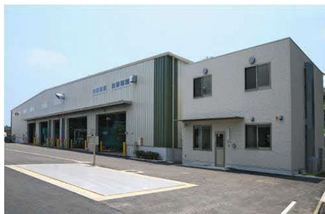
海老名市資源化センター
