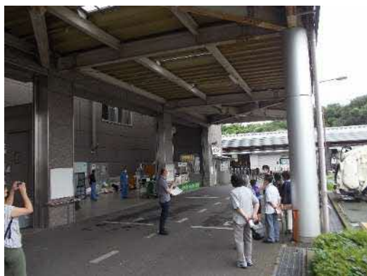
綾瀬市リサイクルプラザ
