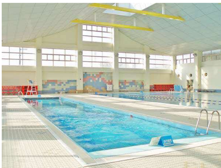
高座清掃施設組合温水プール
