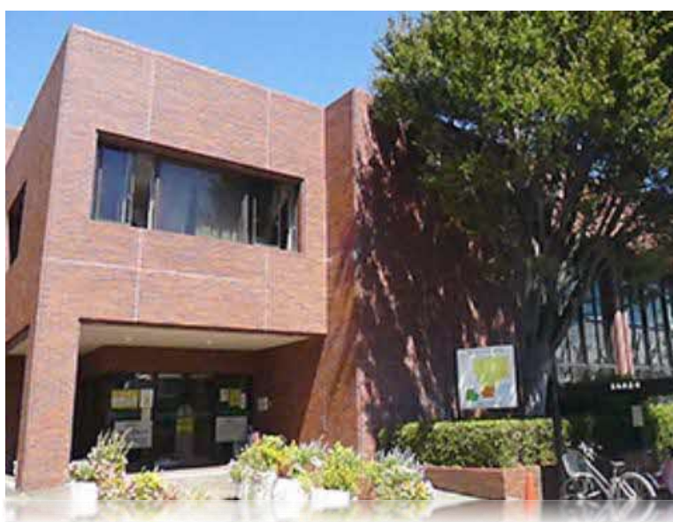
綾瀬市立図書館本館
