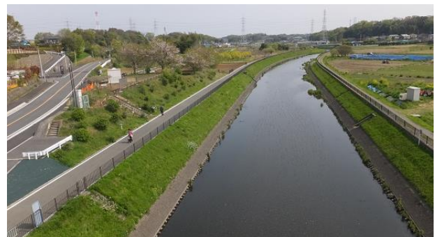
用田大橋2 用田大橋北方面
