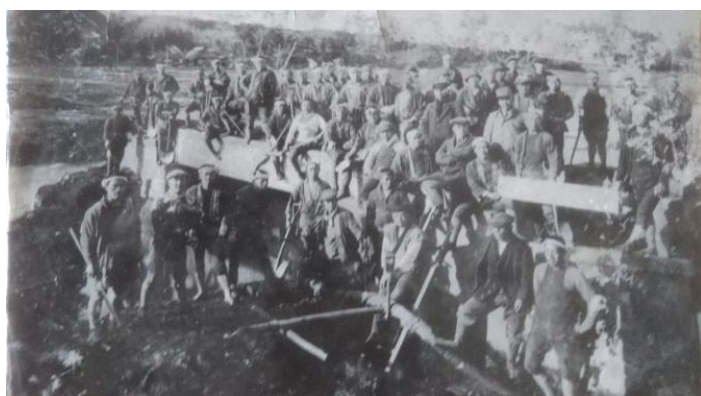
震災直後の堀之内橋の復旧工事の様子 (地域の人が総出で行ったそうです。)
