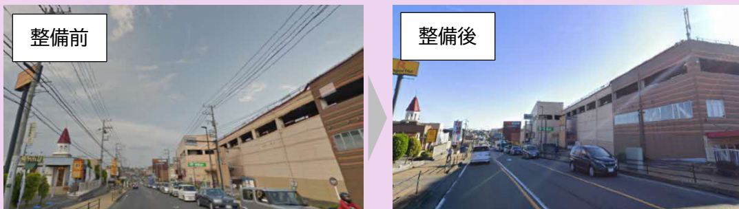
図 市道913号線((都)早川本蓼川線)の無電柱化
