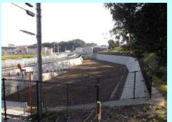
地域生活基盤施設事業 (調整池整備(5号調整池))
