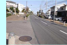
道路事業(市道12号線舗装補修)
