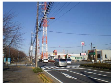
(都) 寺尾上土棚線(市役所周辺)
