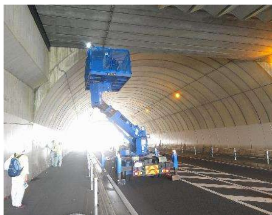
写真 5－2 綾南トンネルの点検状況
