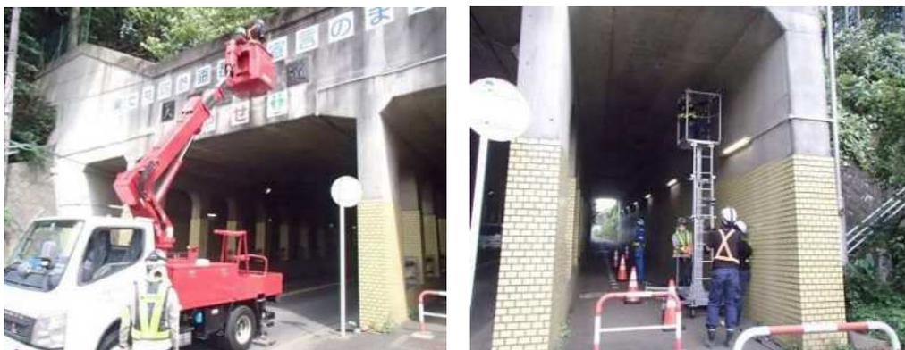
写真5-1 天神森隧道の点検状況
