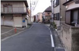
■歩道がない道路
