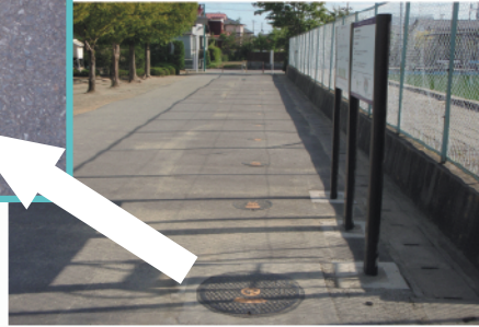
トイレになるマンホールの場所
