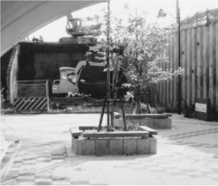
平成15年度、16年度の2カ年で整備が進められている(仮称)中央緑道。平成17年の春には開通する予定です
