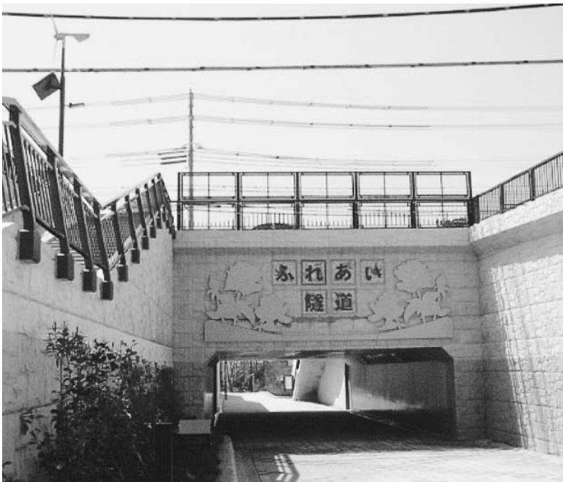
平成16年度に全園が完成した城山こみち。環境に配慮し、風力・太陽光発電併用照明灯が設置されています
