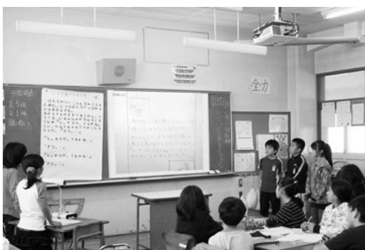
ICT教育を推進するため、小・中学校すべての普通教室に天吊り型のプロジェクトやスクリーンなどを設置しました
