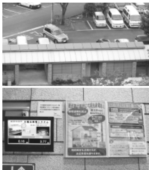
市役所駐輪場屋根の太陽電池モジュール。市役所の電力の一部をまかないます(写真上) 市役所玄関ホールの発電量表示モニター(写真下)
