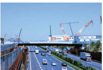
4月16日、東名高速道路に下原橋が架設されました
