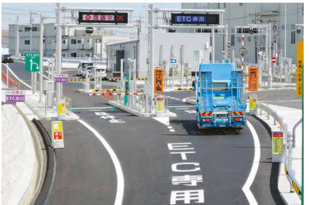
3月31日、綾瀬スマートインターチェンジが開通しました。綾瀬スマートインターチェンジ南側にて。
