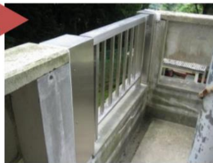
老朽化したバルコニーの手摺を改修
