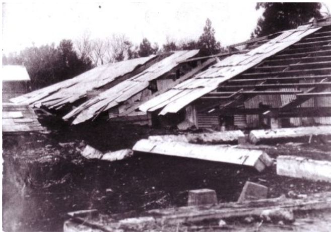
倒壊した校舎（綾瀬小学校蔵）
