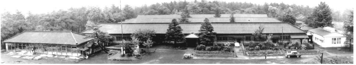
1926(大正 15)年建設の綾瀬小学校旧校舎（解体中を撮影[昭和 39 年]）
