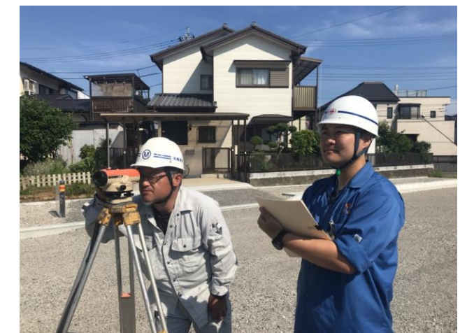
業者との現場立会い作業
